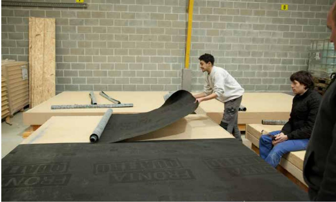
L'assemblage des parois est très similaire à celui des dalles de sol mais il requiert cependant des étapes supplémentaires en termes de fixation (tiges filetées pour le portage), d'étanchéité à l'eau (membrane pare-pluie) ou de bardage sur les faces extérieures (bois de récupération en chêne).
